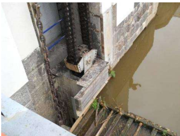
Řetězy, poškozený článkový řetěz vlevo nahoře
